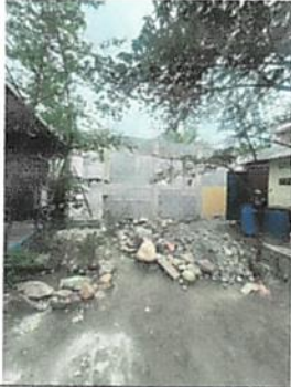
Foto1: AMPLIACIÓN DE COCINA
