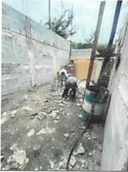
Foto 3: MUROS DE BLOCK EN COCINA
